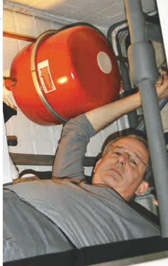
Platz im kleinsten Raum: Der Hauswirtschaftsraum ist kaum größer als 1 m 2 , aber dafür sehr hoch. Das Ausdehnungsgefäß hängt knapp unter der Decke. Auf dem Foto steht Sebastian Schröder auf der Waschmaschine.
