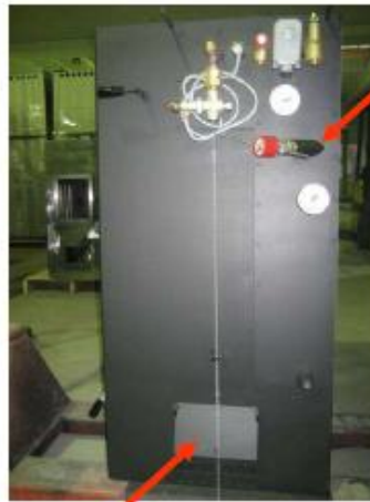
a) Feuerungsregler (schließt Verbrennungszuluft komplett bei 90°C)
